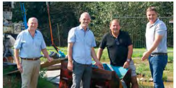
V.l.n.r.: Kassier Johann Tropper, Bgm. Johann Kaufmann, 1. Vizebgm. Fritz Pferschi und Wassermeister Robert Schmid in Reichersdorf beim Pumpversuch des neuen Brunnens. – Kleines Bild oben: Das Brunnenbohrgerät der Firma Forster in Reichersdorf.
