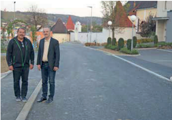
Bgm. Johann Kaufmann und Vizebgm. Fritz Pferschi bei der Besichtigung – Am Parkring zwischen Great Lengths und Haus Drögsler wurde die Straße komplett neu gebaut sowie ein Gehsteig errichtet.
