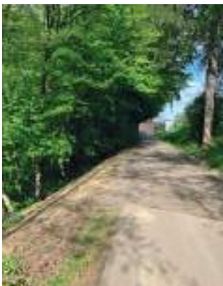
Sanierungsarbeiten: Setzungen in Richtung Dollrath 3.
