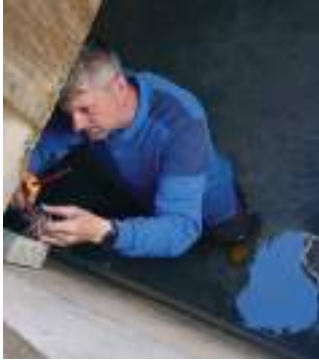
Klärwärter Günther Scherr bei elektrischen Instandhaltungsarbeiten.
