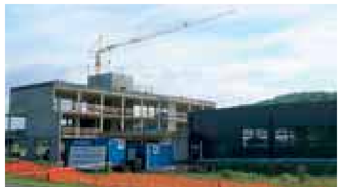
Der Bau voll im Gange.
