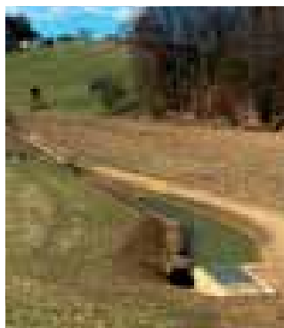
Das Rückhaltebecken in Greith nach der Totalsanierung.
