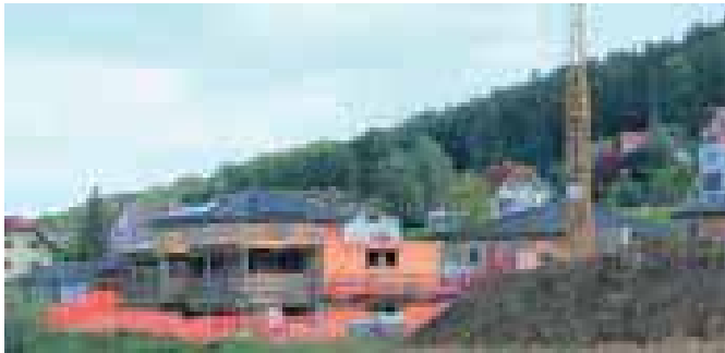
In der Schichenauerstraße errichtet die Firma Hammer-Wohnen den ersten Bauteil einer modernen und exklusiven Wohnanlage mit fünf Wohneinheiten auf drei Etagen. Insgesamt werden vier Mehrfamilienwohnhäuser (Eigentumswohnungen) gebaut.
