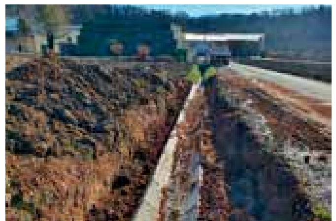
Verlegen von Halbschalen in Aschau
