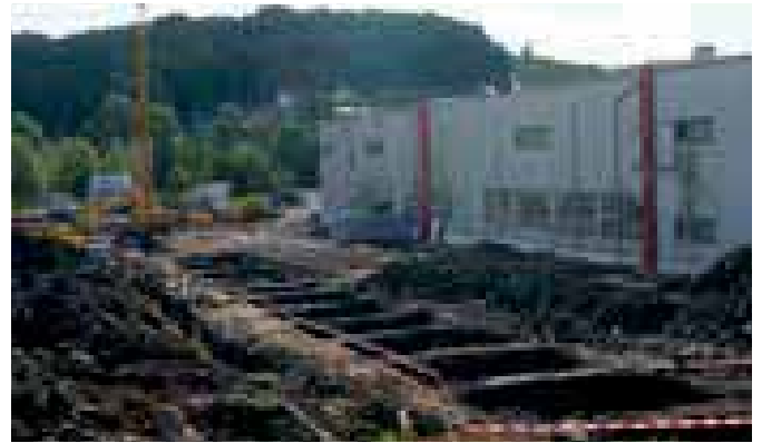
Die große Baustelle der Firma Loidl.
