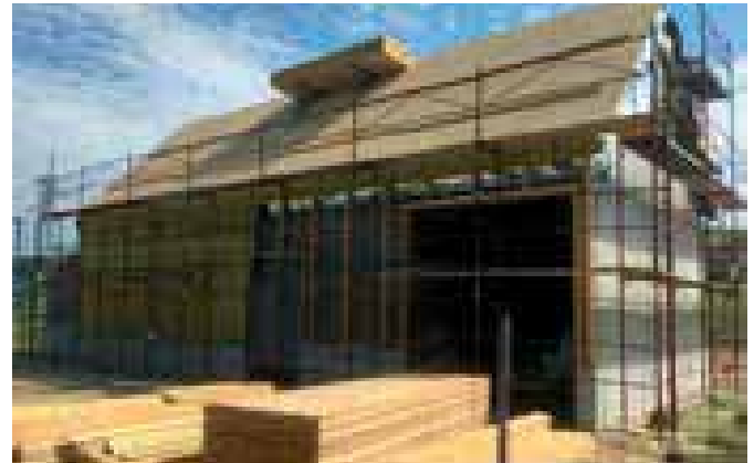
Wasserversorgung Brunnenhaus Reichersdorf.
