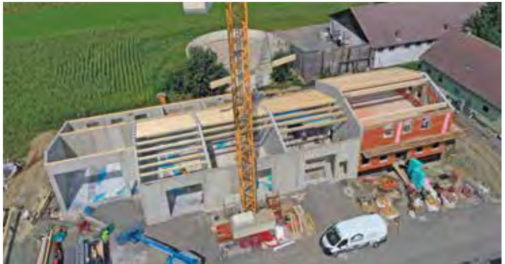
Das Betriebsgebäude bei der Kläranlage ist mitten in der Bauphase.
