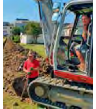
Grabungsarbeiten für die LWL Leitung mit Johann Fasching.
