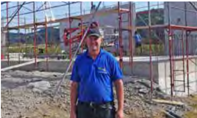
Christian Schadler bei der Baustelle: Brunnen Frauenbach
