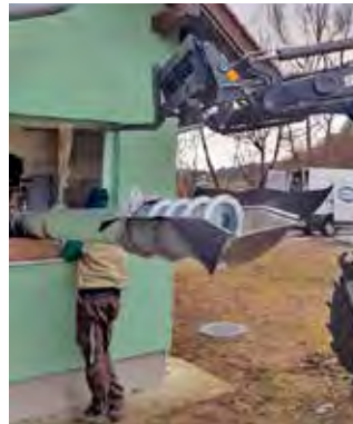
Einbau des neuen Siebrechens bei der Kläranlage Glojach.
