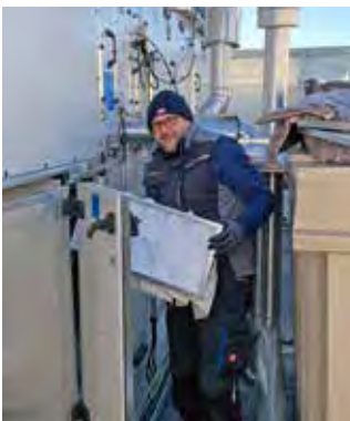
Bernhard Prischink beim Filterwechsel der Belüftungsanlage am Gesundheitszentrum-Dach.
