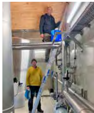
Christian Schadler (l.) u. Andreas Schabl bei der Wartung des neuen Tiefbrunnens Reichersdorf.
