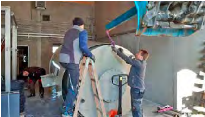
Ewald Mahler, Bernhard Prischink und Helmut Lindner beim Einbringen der drei Fällungsmitteltanks in der neuen Kläranlage.
