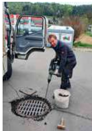
Helmut Lindner beim Anheben eines Abflussdeckels.
