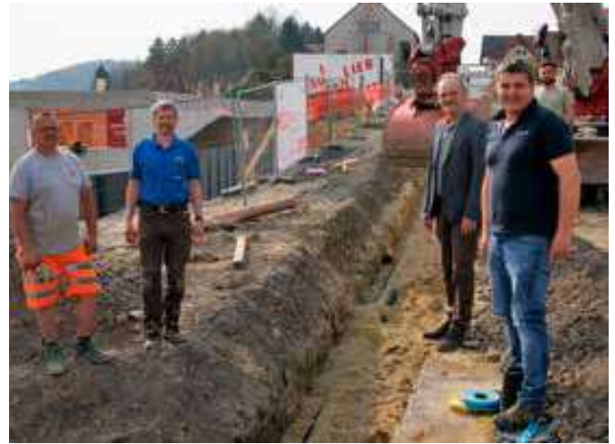
BGM Johann Kaufmann mit Klärwärter Günther Scherr und Wassermeister Robert Schmid auf der Baustelle.
