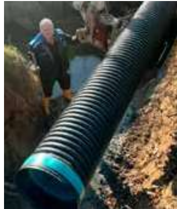
Johann Fasching beim Verlegen der Oberflächenentwässerung.
