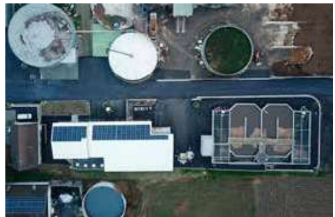
Betriebsgebäude mit Photovoltaikanlage und Klärbecken.
