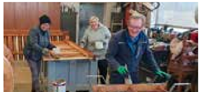
Brigitte Aicher, Karin Nagl und Hannes Schadler setzen die Holzelemente des Pavillons instand.
