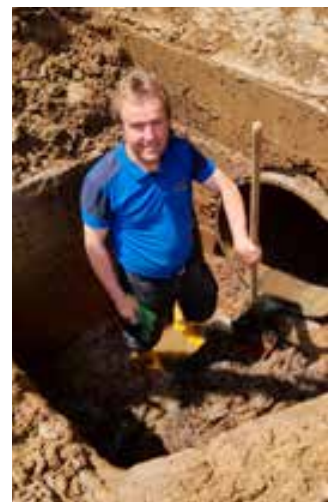
Helmut Lindner beim Beseitigen von Unwetterschäden.
