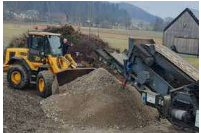
Johann Fasching beim Abtransport des aufbereiteten Bauschuttes.
