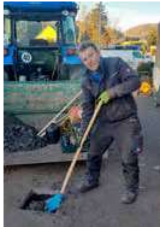
Helmut Lindner bei der Vorbereitung der Stützfundamente. (Haltestelle Friedhof)
