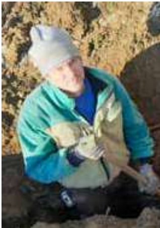
Günther Scherr bei der Reparatur eines Kanalrohres.
