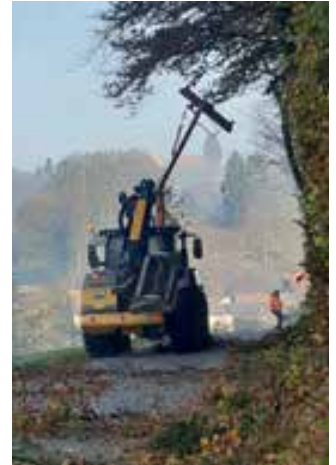
Unsere Mitarbeiter beim Entfernen von überhängenden Ästen auf Gemeindestraßen.
