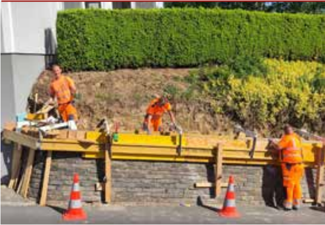
Sanierung der Stützmauer bei Lafer-Tropfer in Aschau.
