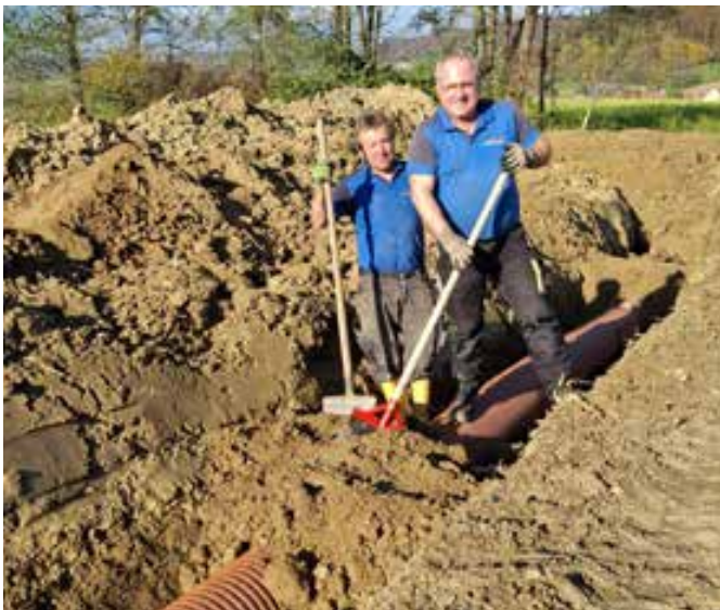
Die Gemeindefacharbeiter Johann Fasching und Helmut Lindner bei Sanierungsarbeiten bzw. der Verrohrung in Tagendorf.
